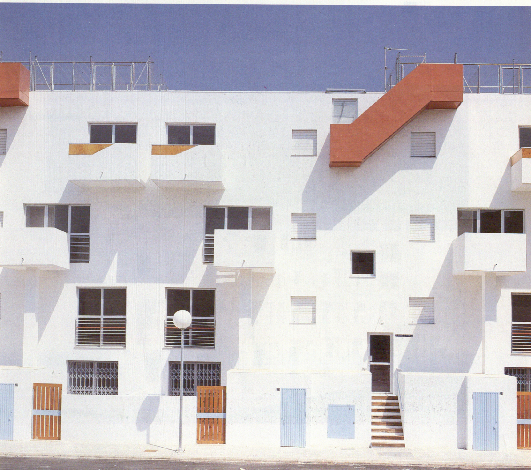
1. Detalle de fachada. Bloque 2.
